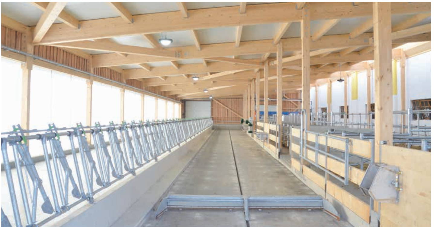
Fressplatz mit Antritt und Laufgang mit Kura P Matten bringen die Weide in den Stall.
