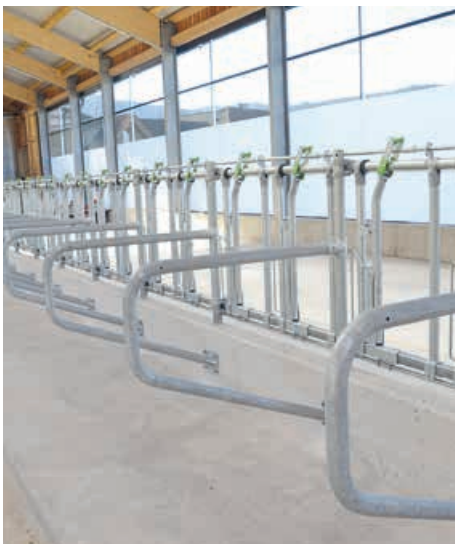
Fressplatzteiler gedübelt.
